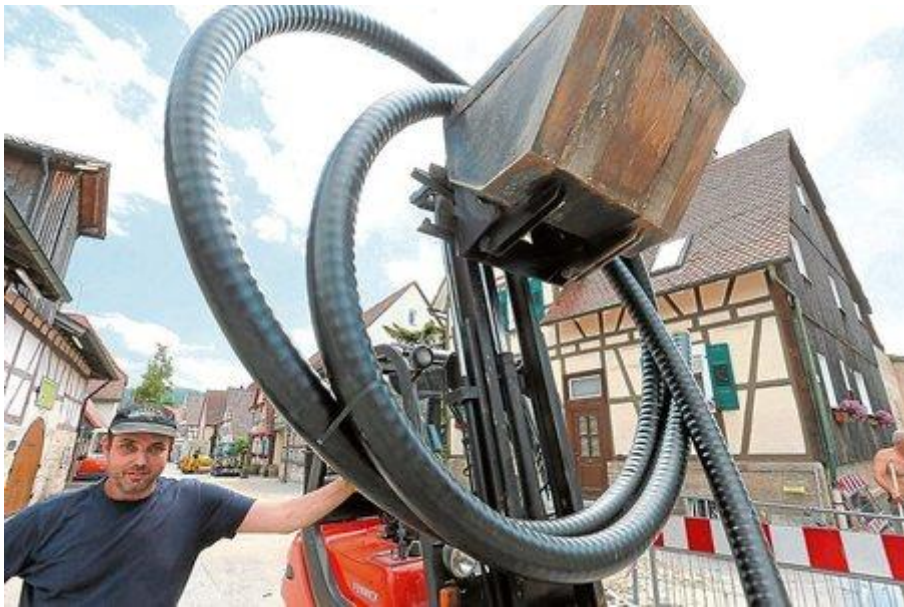
Jungunternehmer Jürgen Laub beim Verlegen der Fernwärmeleitung in Ochsenbach. Foto: Alfred Drossel
