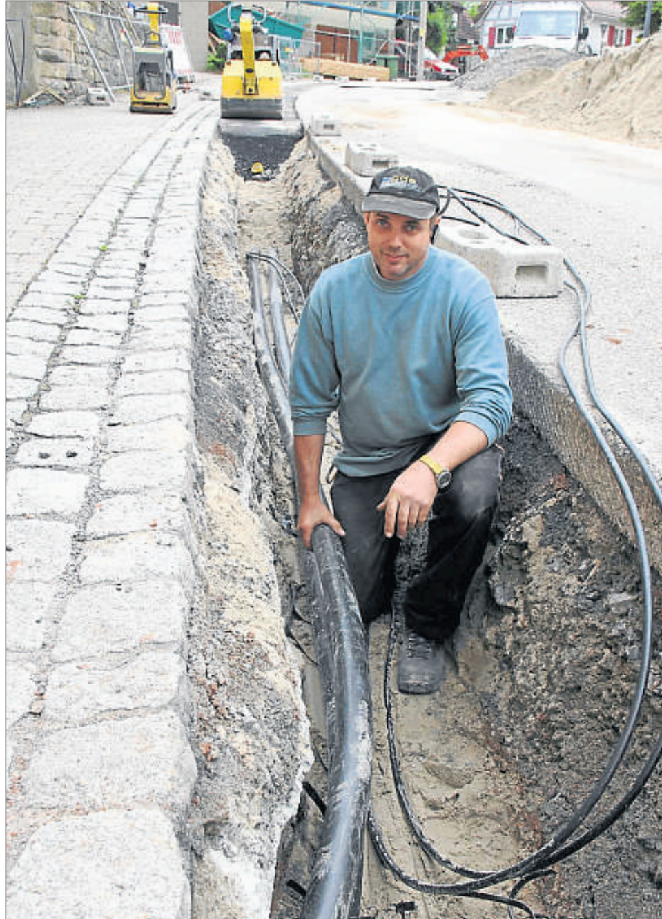
Die Verlegung der Versorgungsleitungen – hier in der Dorfstraße – ist bald abgeschlossen.
