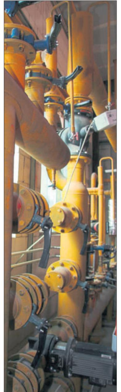
Am Heizkessel nehmen die Leitungen die Wärme auf und das warme Wasser wird in Richtung Kundschaft gepumpt.
